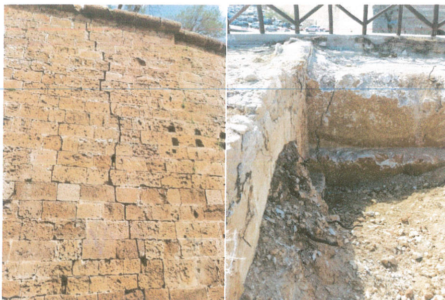
Εικόνα 5. Διαμπερείς ρηγματώσεις
