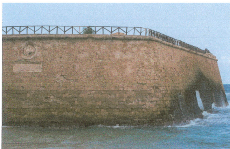
Εικόνα 6. Εικόνα της φθοράς και της εξαλλοίωσης των λίθων. Η έντονη φθορά οφείλεται και στην πολύ χαμηλή αντοχή των ψαμμιτικών ασβεστόλιθων της λαξευτής όψης.
